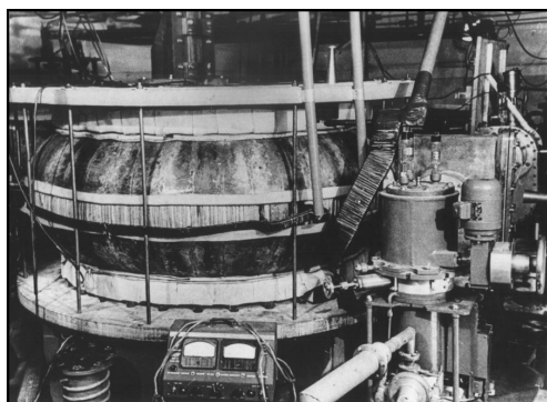
Primeiro Tokamak fabricado no Instituto Kurchatov de Moscou, em 1958. https://upload.wikimedia.org/wikipedia/commons/e/e5/Tokamak_T-1.jpg
